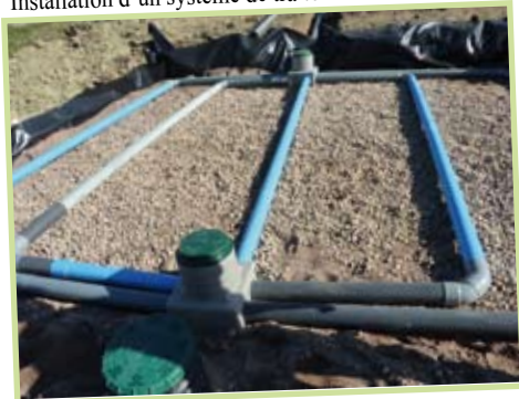
Installation d'un système de traitement des eaux usées
